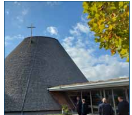
St. Josef – Holzkirchen – Außenansicht
