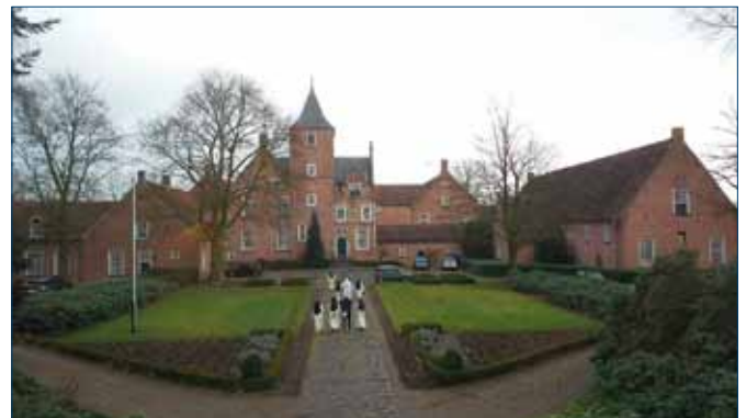
Priorij Sint Catharinadal Oosterhout (Gesamtansicht)
